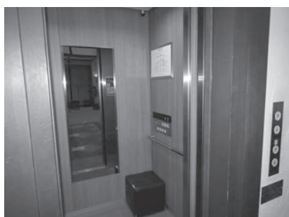
エレベーター設備更新
