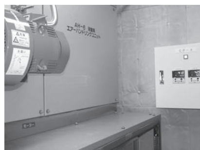
空調機器設備更新
